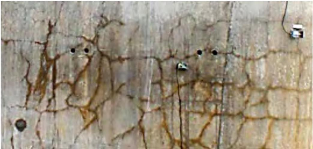
*Figure 1. Béton dégradé par la RSI*
